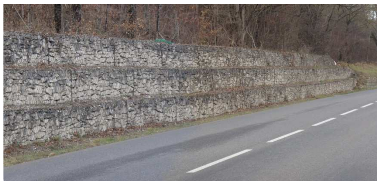
Figure 20 : Commune de Lauzerte Lieu dit « Serre Sèque » Ancien grand glissement stabilisé par des gabions
