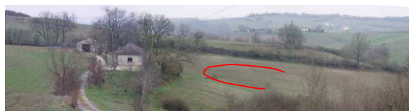
Figure 14 : Commune de Cazès Mondenard Lieu dit « Carrieu » Ancien glissement supposé
