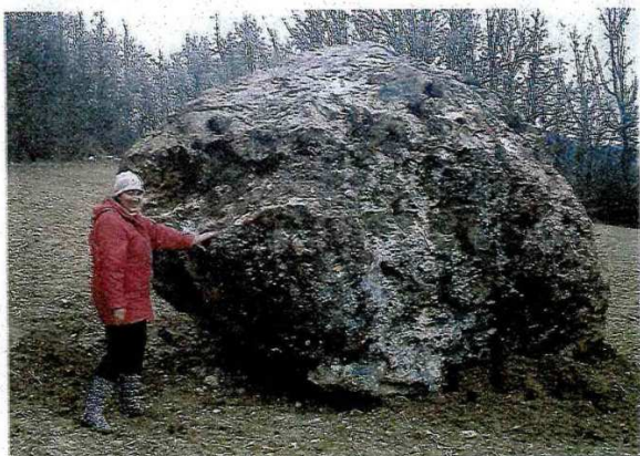
Figure 19 : Commune de Lauzerte Lieu dit « Les Boutes » Chute de gros bloc survenue en janvier 2013
