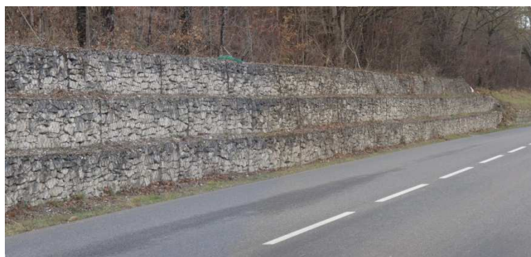
Figure 20 : Lieu dit « Serre Sèque » Ancien grand glissement stabilisé par des gabions
