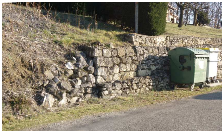
Figure 22 : Lieu-dit Frayssé– confortation par mur puis gabions
