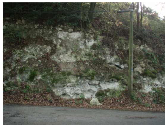
Figure 18 : Commune de Sauveterre Lieu dit « VC 3 » Topographie suspecte
