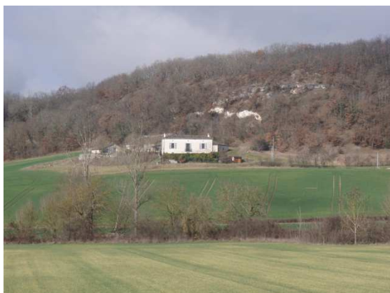
Figure 17 : Commune de Bouloc Lieu dit « Falsegarre » Chute de pierres
